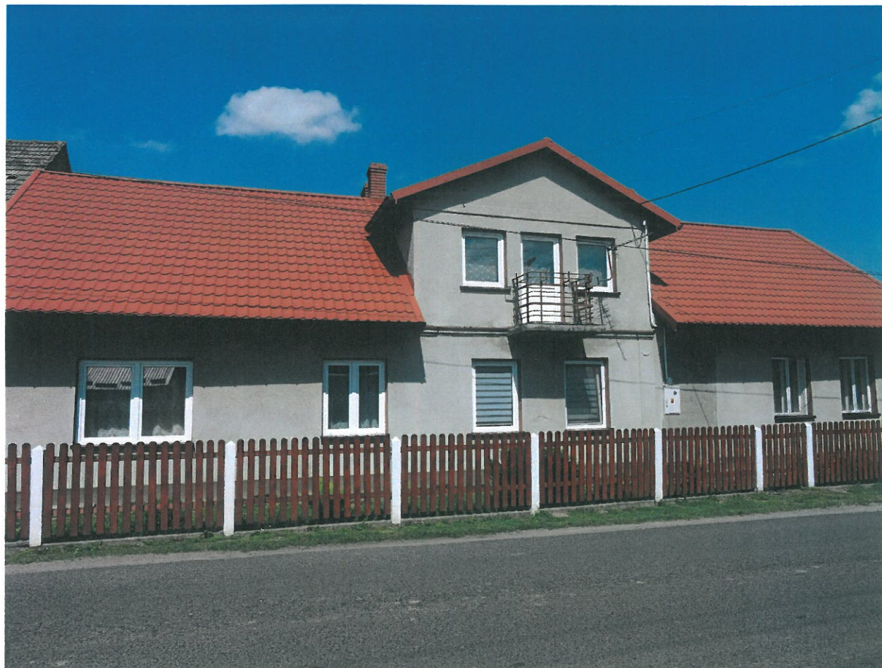
Widok na elewację południowo-zachodnią
